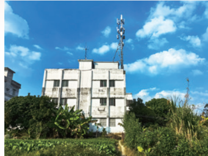
● 樓面支撐桿加固應用
