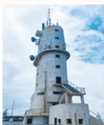
● 上海雞骨礁島嶼基站
