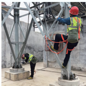
● 泰安分公司運營維護作業現場
