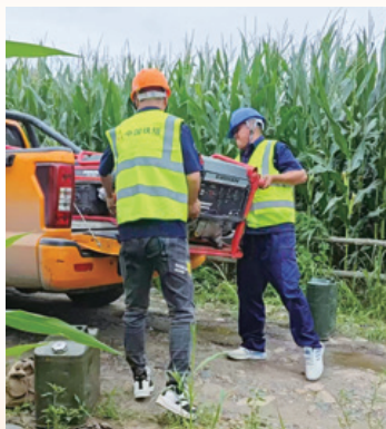
● 吉林分公司暴雨洪澇應急保障作業現場
