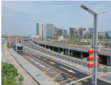
● 河南鄭州通信基站建設融入城市微景觀
