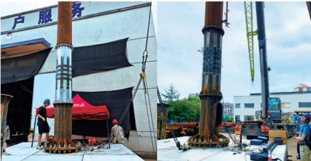
▲ 已有站址碳纖維加固
