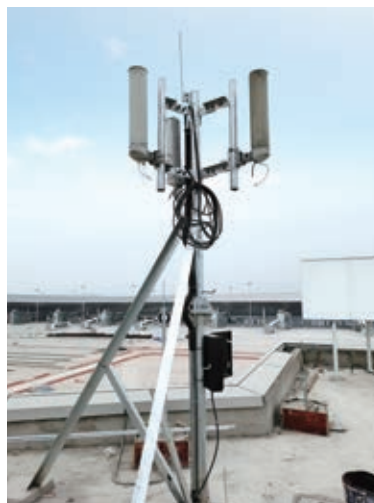
▲ 利用廊橋建設通信塔
