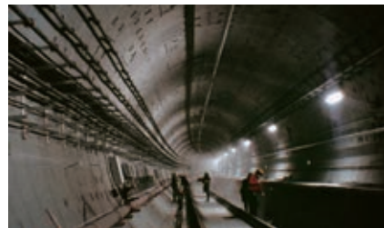
▲ 地鐵漏纜佈設現場
